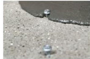
3 Installazione connettori Steel Connect.
