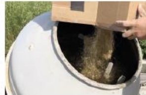
2 Miscelazione del sistema Geolite FRC.
