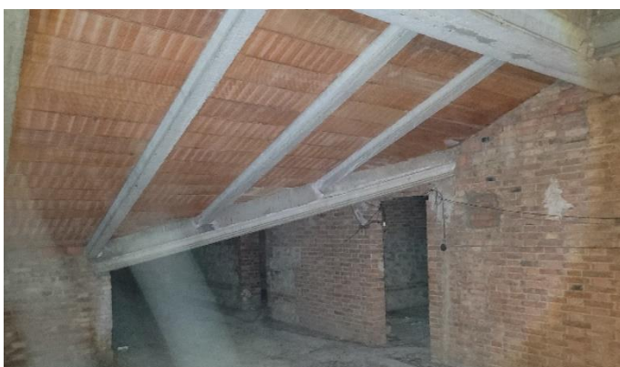
Figura 7 Intradosso del solaio di copertura in travi in c.a. e tavelloni.
