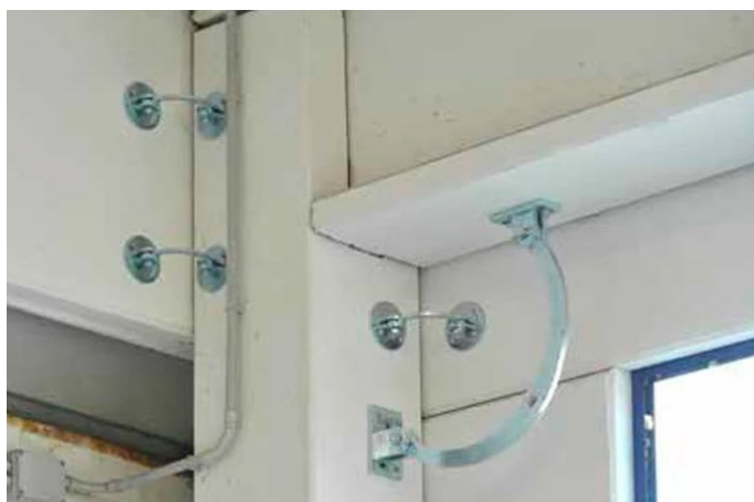
Serie di dissipatori stabilflex posti in opera
